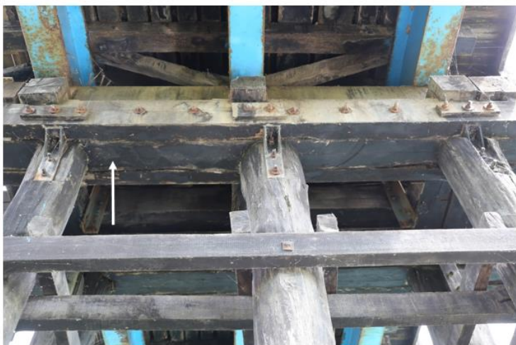
Slika 40. Gornji dio drugog stupišta. Naglavne grede su mehanički uslojene, sa malim tragovima propadanja na bridovima sljubica. Poprečne grede imaju zdrava čela, stupovi ne pokazuju niti trulež obložnog pojasa bjeljike. Strelica pokazuje položaj i smjer vađenja izvrtka na mjernome mjestu MM2.
