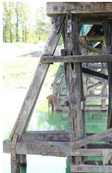
Slika 33. Stupište IV. Natruo kosnik do polovine visine, stup potpuno zaražen u cijeloj visini.
