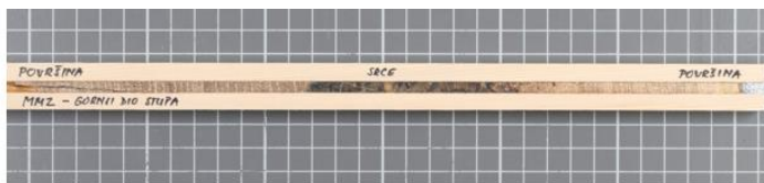
Slika 18. Obradeni izvrtak iz cijelog proboja stupa na MM 2 (II stupište, gornji dio stupa ispod naglavnih greda). Tipična slika uz gornji čelni presjek pilota gdje je površina djelomično vrlo plitko oštećena ali suha, dok je središnja srčana zona trupca/pilota zaražena i natrula u širini od 8 – 10 cm.
