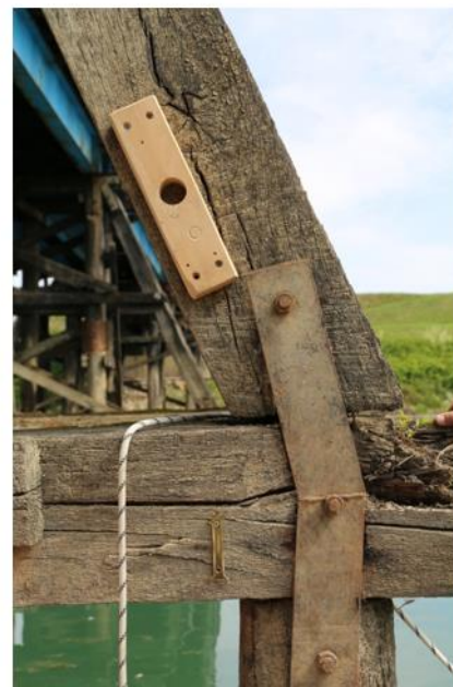
Slika 11. a) i b). MM 1. Mjesto cilindričnog izvrtka ca 30 cm iznad trulog čela kosnika (slika desno) pokazuje da je površina zaražena i izjedena do dubine od ca 2 cm, dok dublje zone izgledaju kompaktno i zdravo.
