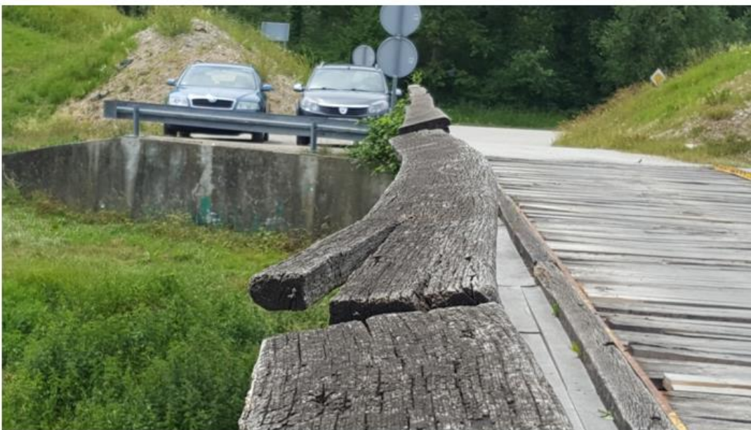
Slika 2.12 Uzdužna deformacija rukohvata uslijed isušivanja, a uzrokovano nepravilno piljenom građom i nedostatnim pričvršćenjem.
