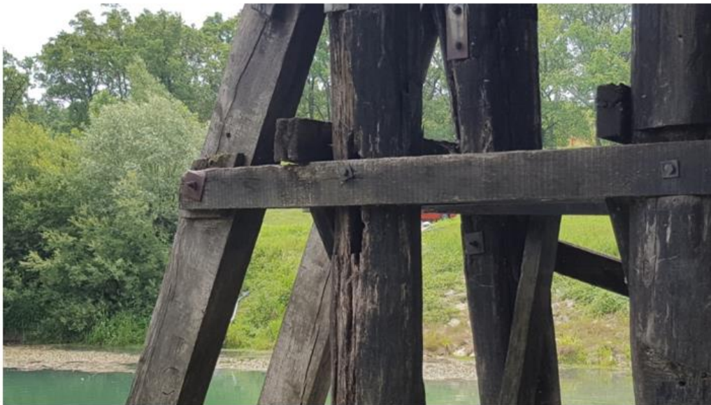
Slika 2.44 Stupište (jaram) 4 – Stup smanjenog poprečnog presjeka izvana te istrunuo u potpunosti iznutra. Djelotvoran poprečni presjek stupa iznosi svega 20%
